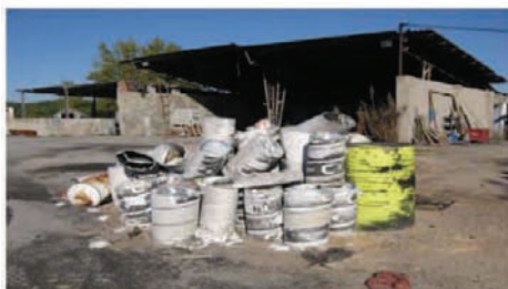
ABANS DE LA DECONSTRUCCIÓ
